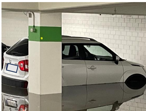
Überschwemmung im Parkhaus Post, 5.9.24
