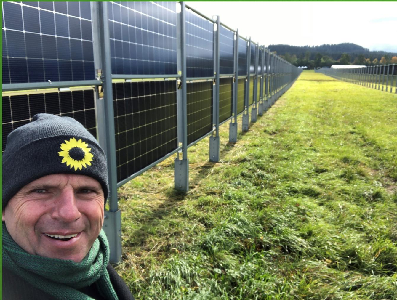
Vertikale Bifaciale Agri-PV Anlage
